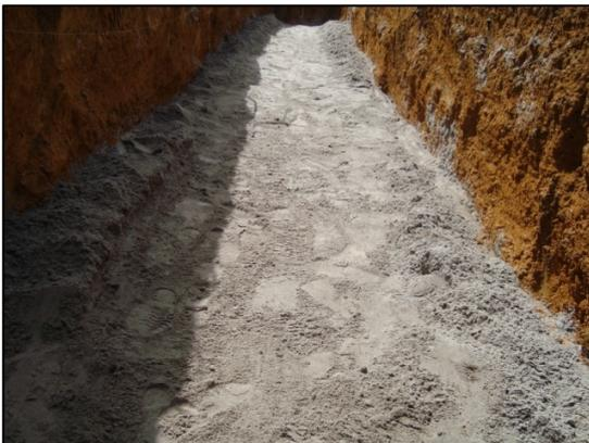
Leito de assentamento nivelado e compactado
