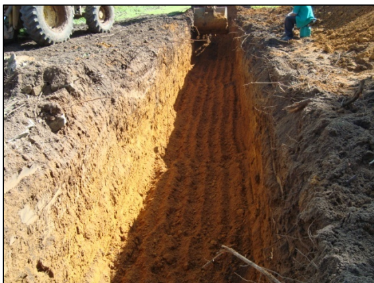
Abertura da vala
