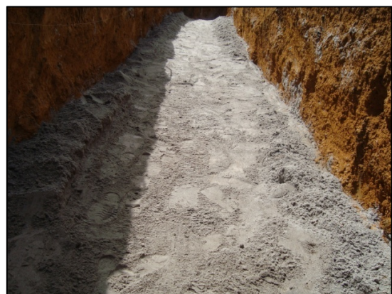
Leito de assentamento nivelado e compactado
