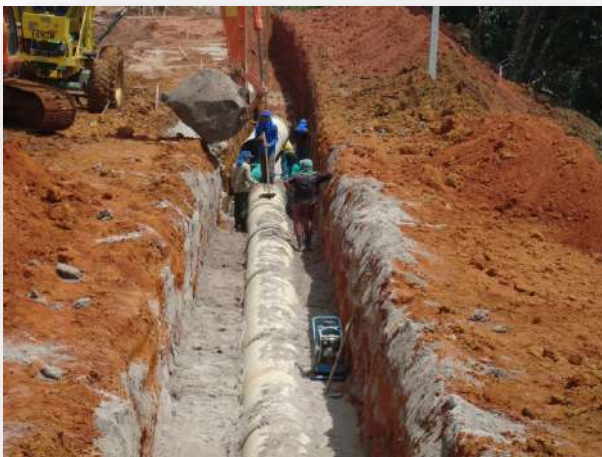
Foto 09 Reaterro com areia adensada
