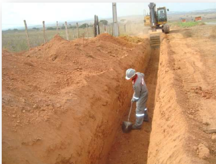
Foto 07 Abertura da vala
