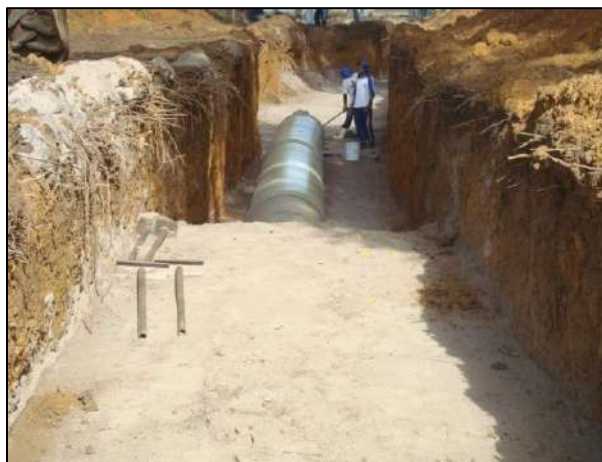
Foto 11 Reaterro secundário com 300 mm sobre a geratriz superior.
