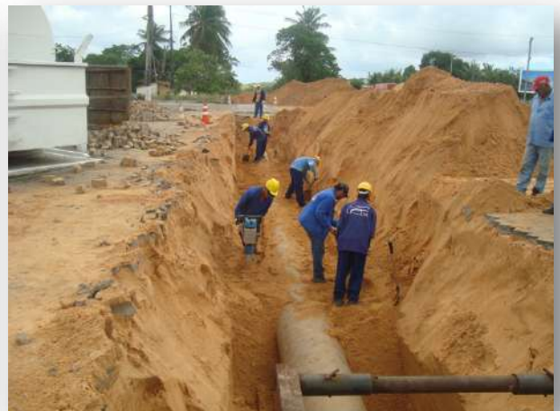
Foto 10 Reaterro com solo nativo
