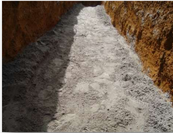
Foto 08 Leito de assentamento nivelado e compactado
