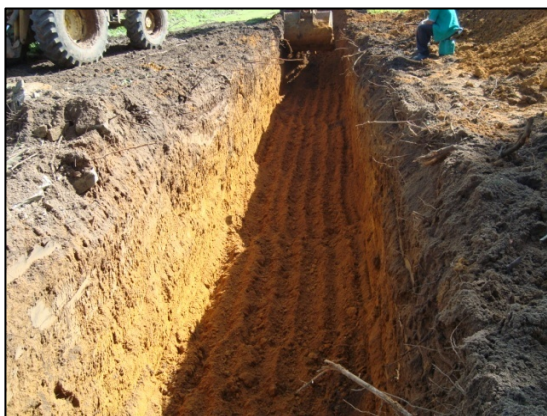
Abertura da vala
