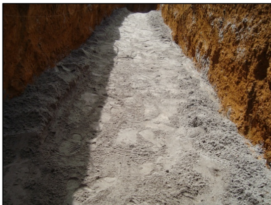
Leito de assentamento nivelado e compactado
