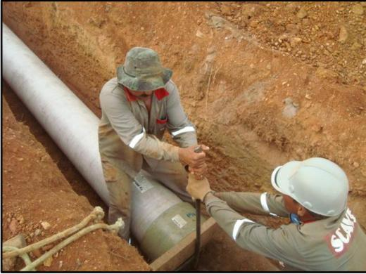
A – Por meio de alavanca, tomando o cuidado de colocar um pedaço de madeira na extremidade do tubo, para protegê-lo.
