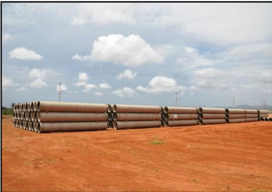
O armazenamento dos tubos deve ser em terreno plano, e podem ser apoiados nas madeiras utilizadas no transporte.
