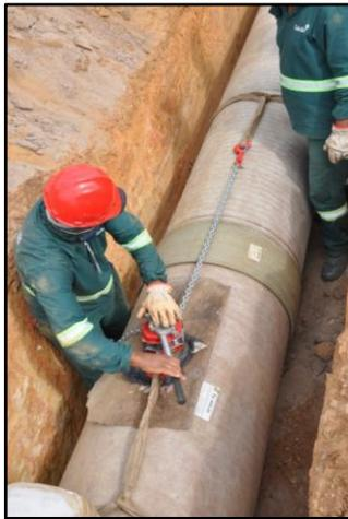
B – Utilizar Tirfor/catraca, com duas cintas de Nylon, sendo uma acoplada no Tirfor/catraca e a segunda, envolvendo o tubo que vai ser acoplado. Colocar um lençol de borracha ou similar, entre o tubo e o elemento de montagem, para que não haja contato entre eles. Ao utilizar esse método, tenha a certeza que o tubo já instalado esteja suficientemente ancorado, para não permitir que se mova durante a junção e afete conexões feitas anteriormente.
