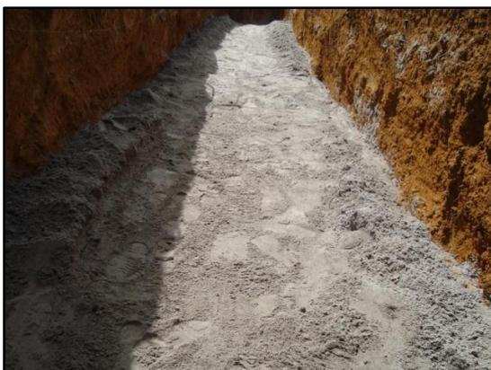
Leito de assentamento nivelado e compactado
