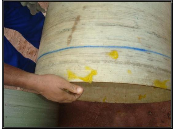
Aplicação de pasta lubrificante para instalação da luva de correr.
