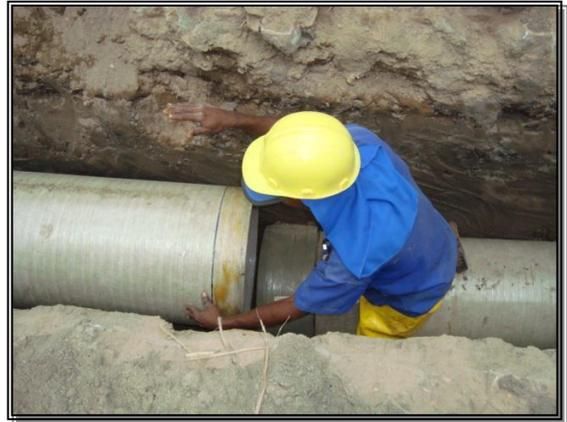
Limpeza e aplicação de pasta lubrificante nas extremidades (Ponta e Bolsa).
