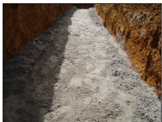
Leito de assentamento nivelado e compactado
