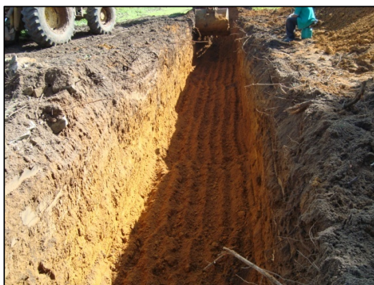
Abertura da vala
