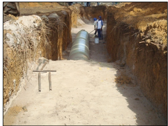
Reaterro secundário com 300 mm sobre a geratriz superior
