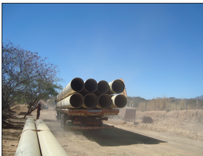
Transporte dos tubos do local de armazenamento para o local de montagem
